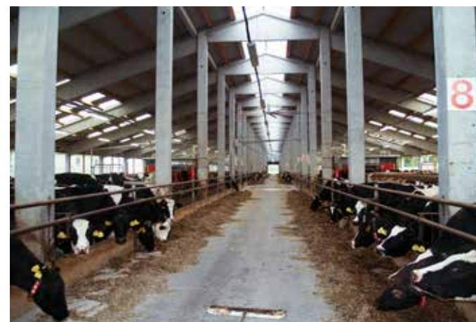
Slika 30. Kombinovani konstruktivni sklop drvo-čelik, Kozarska Dubica (BiH), 2014, gore i beton-čelik, Češka Republika, 2007, dolje (Izvor: Autori)
