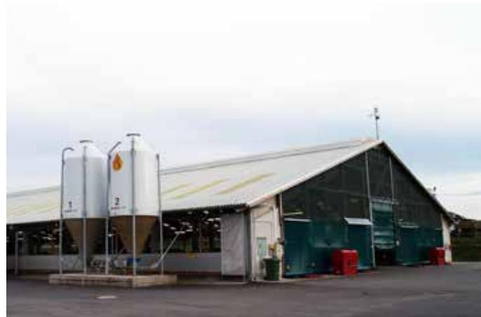
proizvoda i nemogućnost stvaranja kondenzacije. Svaki silos ima skalu koja pokazuje tačnu količinu hrane koja se u njemu nalazi ili na bočnoj strani silosa postoji providni dio pomoću koga se vizuelno može utvrditi napunjenošć silosa. Silosi se mogu puniti pneumatskim putem preko noge ili transporterom preko otvora na vrhu silosa (Sano tehnika; JOMAPEKSb).
