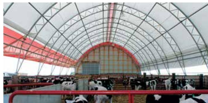
Slika 35. Primjena PVC folije u materijalizaciji staje – šatorski sistem (Izvor: ClearSpan)
