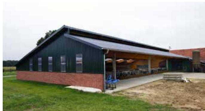
Slika 37. Savremen poljoprivredni objekat sa konstrukcijom od prefabrikovanih AB stubova i nosača od lameliranog drveta (Izvor: Brueninghoff)
